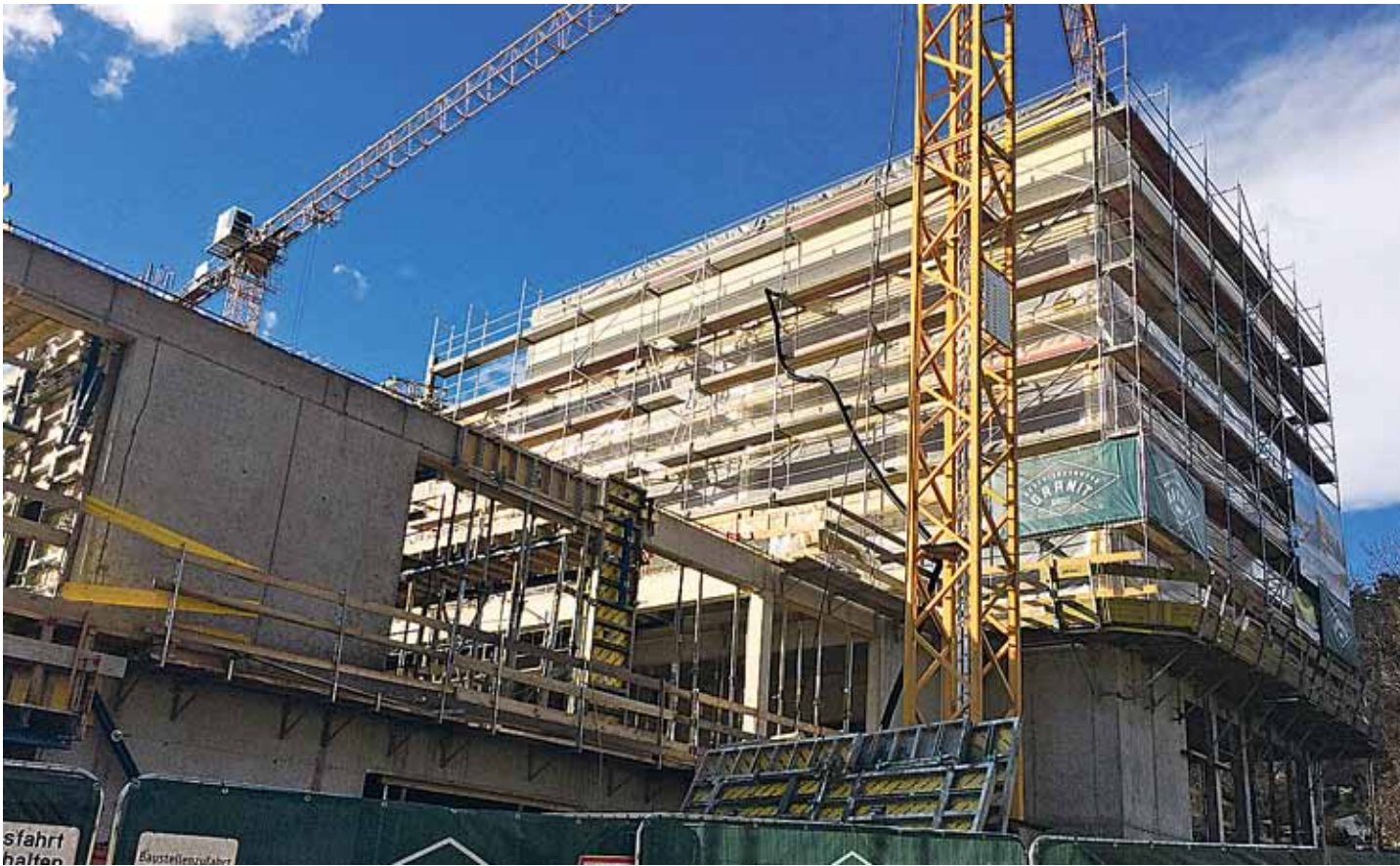
4.700 Kubikmeter Beton, 422 Tonnen Stahl und 625 Festmeter Holz stecken im neuen Steiermarkhof
