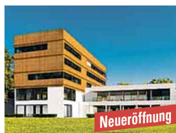
2016 bis 2017: Um- und Neubau des Steiermarkhofs: es entsteht ein technisch modernisiertes Veranstaltungs- und Bildungszentrum
