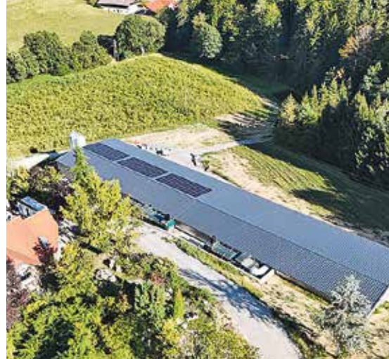
Mit einem österreichweit erstmals verbauten Lüftungssystem startet Marco Potzinger in die Freiland-Legehennenhaltung
