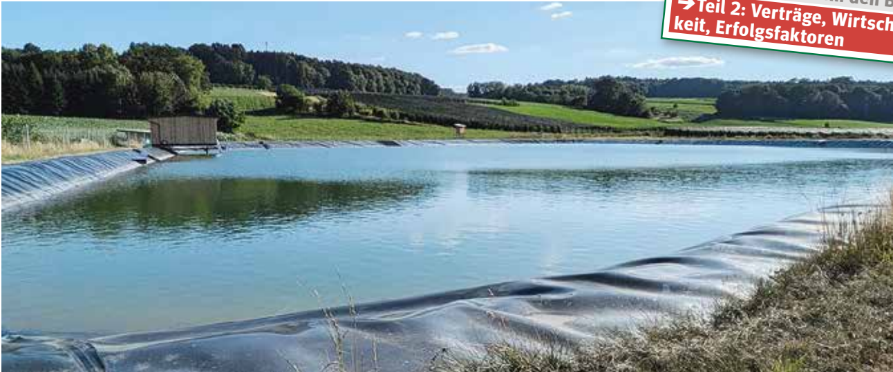
Speicherbecken, wie hier in Hohenegg, sind meist Kooperationsprojekte mehrerer Betriebe MUSCH
