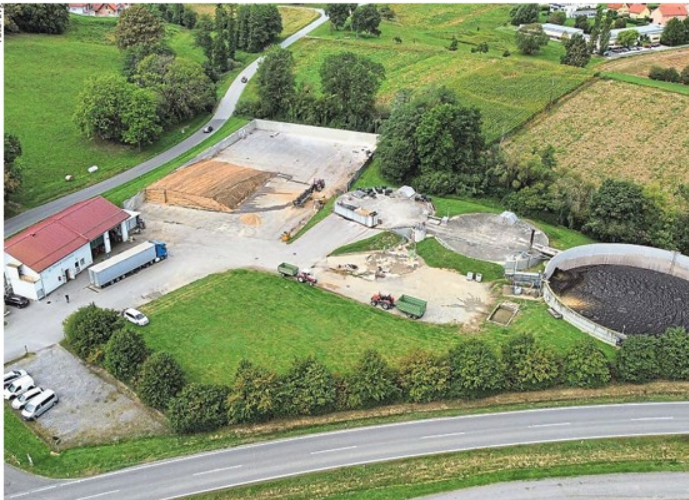
21 steirische Biogasanlagen müssen umgerüstet werden, um direkt ins Gasnetz einzuspeisen
