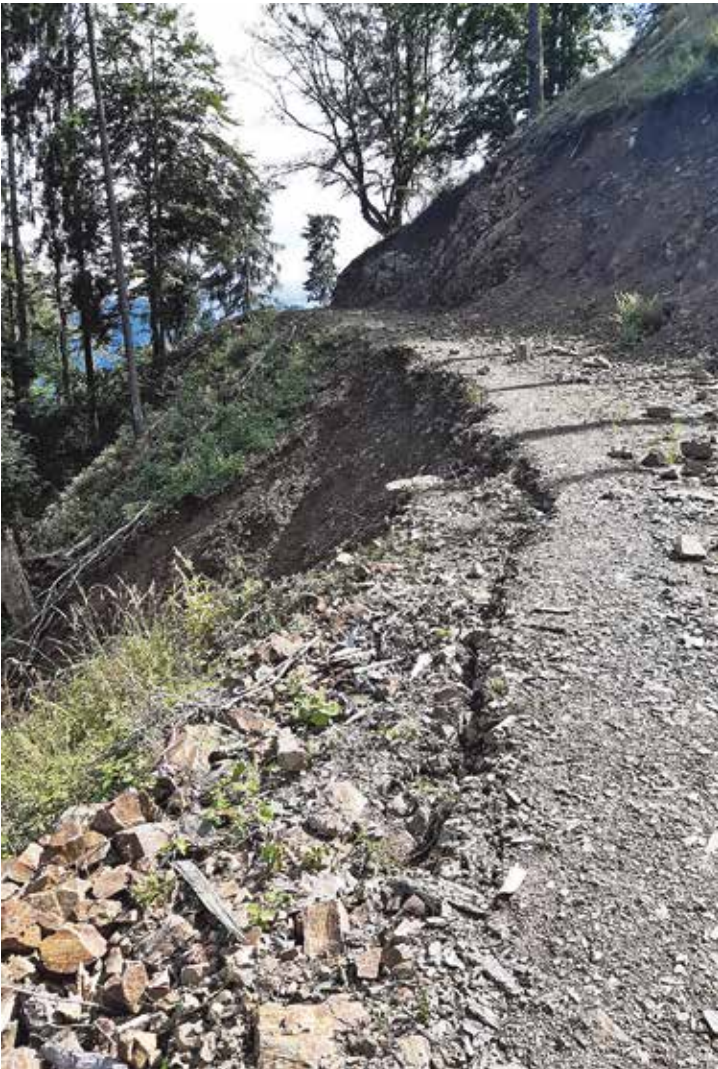
Nach Dauerregen abgerutschte Böschung
