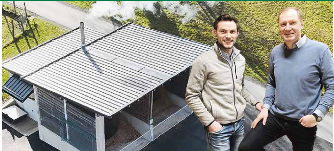
Zwei Hack-schnitzelkessel mit je 150 Kilowatt versorgen über 850 Meter Wärmeleitung 14 Abnehmer mit einer Anschlussleistung von 260 Kilowatt KK
