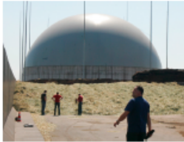
In der Steiermark gibt es insgesamt 37 Biogasanlagen. APA/Hautzinger
