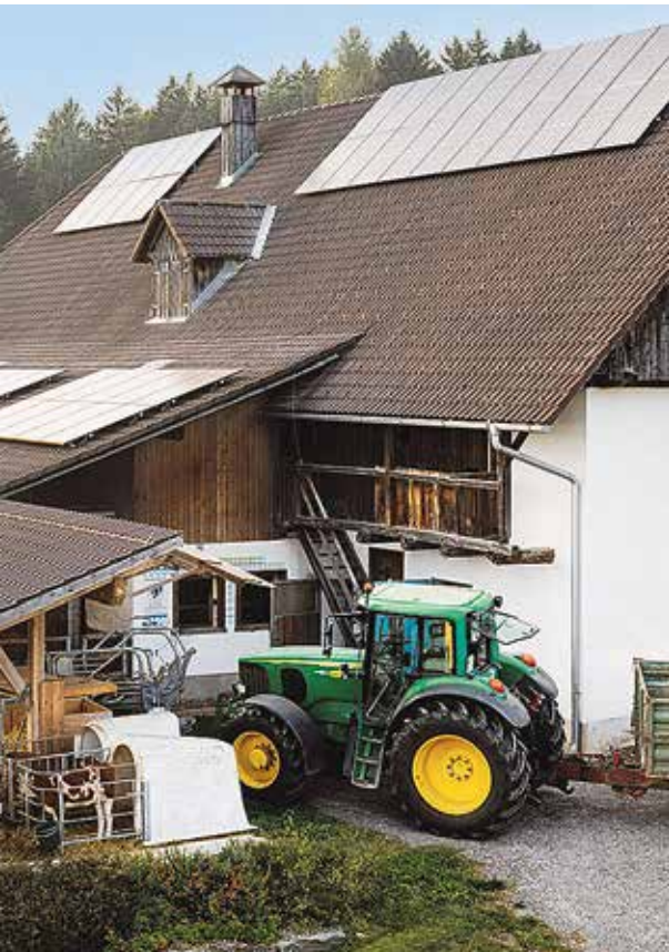
Als Faustformel sollte die Leistung der PV-Anlage mindestens einen kWp pro 1.000 kWh Jahresstromverbrauch und die Kapazität des Batteriespeichers in etwa die Hälfte der PV-Leistung entsprechen STIEFKIND (13)
