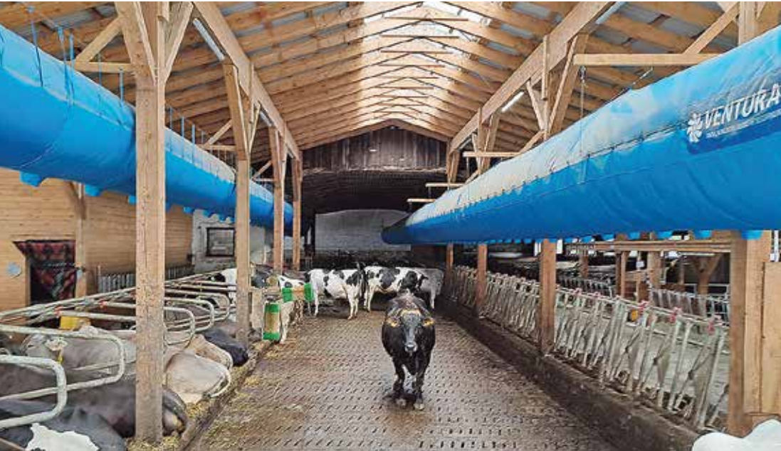
AK MILCH Tubes werden individuell berechnet und an den Stall angepasst
