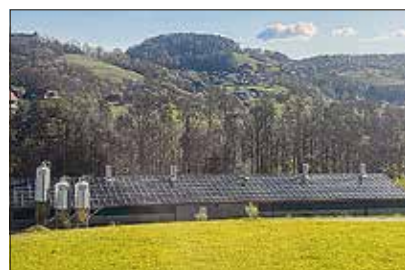
Mit Photovoltaikanlage ist Biogeflügelmast Haider am Weg zur CO 2 -Neutralität
