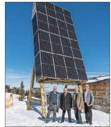
Die PV-Pappel nutzt die Schneereflektion aus und erzeugt im Winter so zehnmehr Strom als herkömmliche Anlagen, so Heinz Kopetz (2.v.r.) SEBA
