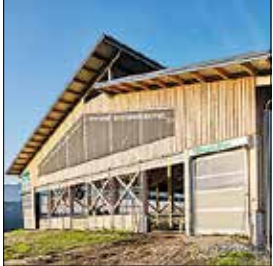
Der vierreihige Laufstall mit zwei außenliegenden Futtertischen und Curtains, Melkroboter, Futter- und Spaltenschieber ist auf Tierwohl und effiziente Arbeitsabläufe getrimmt. HOLZBAUPREIS/G. OTT, GISELBRECHT
