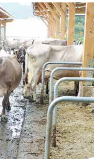
Kurzstand, Laufgänge mit Quergefälle, Harnrinne und Befeuchtung zählen zu den ammoniakmindernden Baulösungen im Rinderstall. KNIPEISS, EIP RIND
