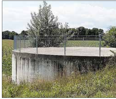
Abgedeckte Güllelager. Generell sind abgedeckte Gruben (z.B. Betondecke, Zeltdach) besser als offene Gruben. Die Abdeckung der Güllebehälter minimiert den Luftaustausch über die emittierende Oberfläche der Gülle. NEUBAUER
