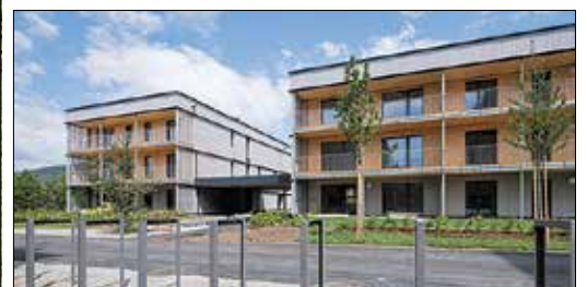
LIEB BAU, PIERER, LUNGHAMMER
