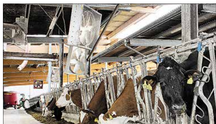
Mit einer Untersichtschalung kann der Hitzeeintrag über das Dach wesentlich gemindert werden. ARBEITSKREIS MILCH
