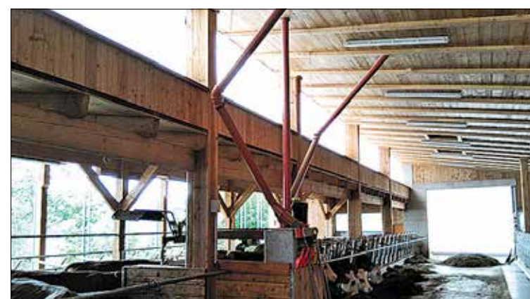
Mit einer Untersichtschalung kann der Hitzeeintrag über das Dach wesentlich gemindert werden. ARBEITSKREIS MILCH
