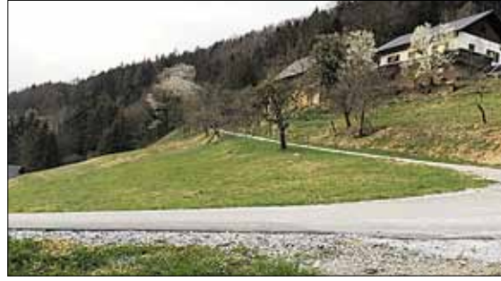
Der Gschätzenweg ist die einzige Zufahrt zu drei Höfen, drei Wohnhäusern und einem Wasserspeicher
