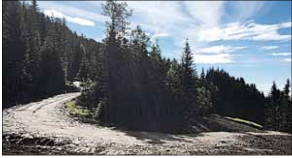
Die 840 Meter lange Forststraße Klughiasl nach Fertigstellung der Rohtrasse
