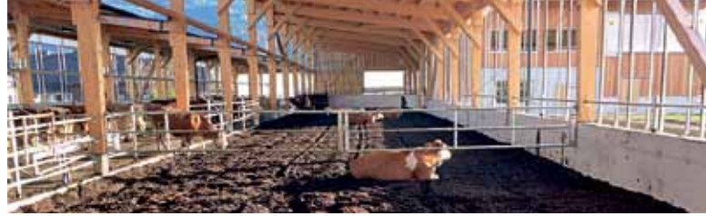
Im Schulstall wurde bewusst viel Technik eingebaut BREININGER
