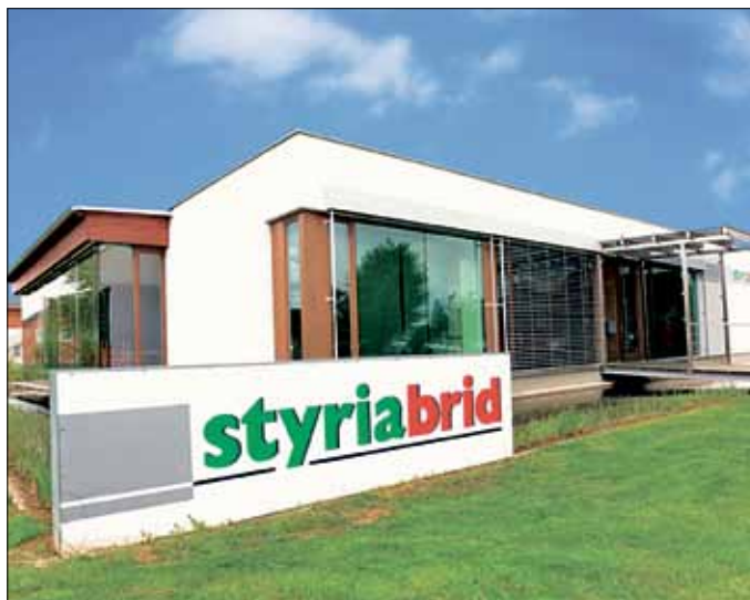
Zentrale in St. Veit im Vogau
