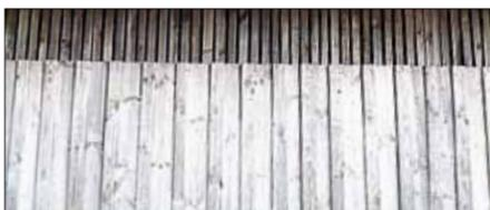
**Befahrbarer Futtertisch und Spaceboardwand zur Belüftung und Belichtung**
