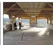
**Das Futterförderband ist vom Traktor aus bedienbar, Erhöhungen sind von Bodenplatte getrennt betoniert**
