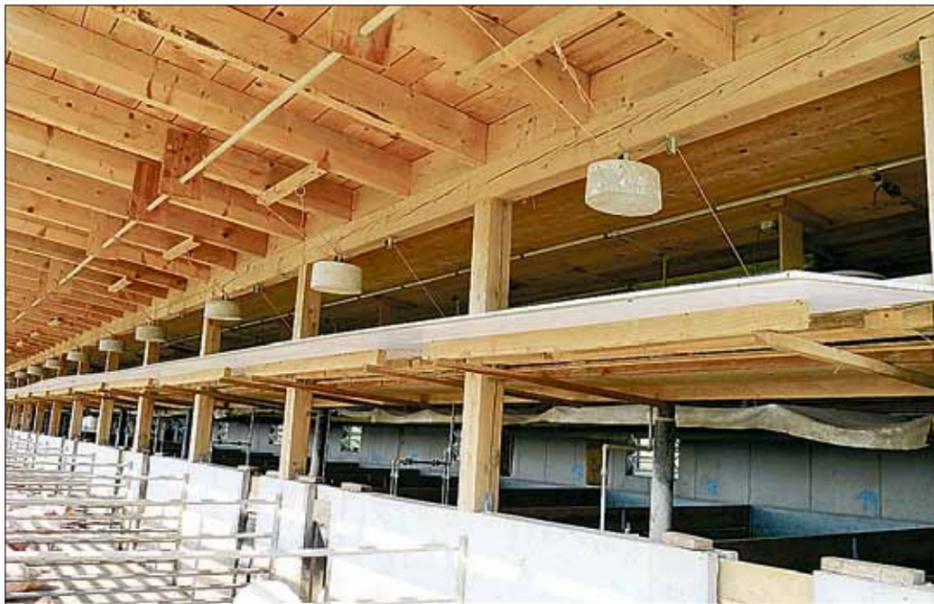
Typisch für alle Pig-Ports: Auslauf und technisch einfach gelöste Lüftung über Fenstern und Klappen
