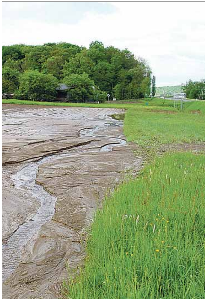
Grünstreifen schützt Straße und Graben vor Anlandung ARCHIV
