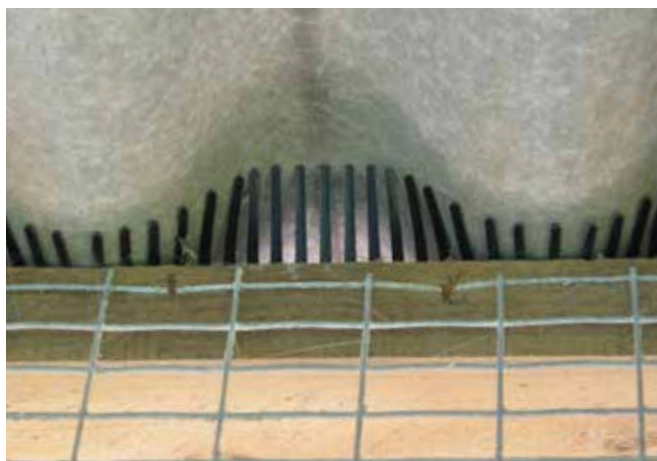
Vogelschutzmaßnahmen, Quelle: Mayringer, LK OÖ
